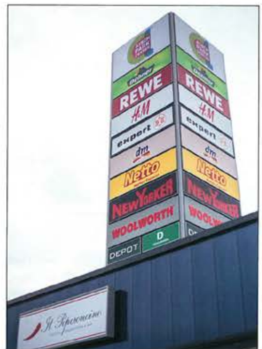
Der Pylon ist mit 96 Leuchttransparenten bestückt.
